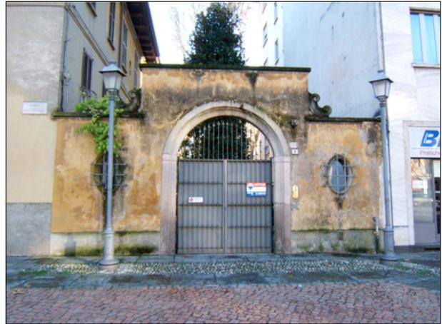
estesa alle imposte e spalle realizzate in granito "Rosa Baveno". Aperture laterali ellittiche contornate da fascia in cemento decorativo ed inferriate. Profilo della cinta muraria spezzato con superiori copertine in cemento accompagnate da elementi modanati e raccordato da coppia di volute in cemento decorativo.
