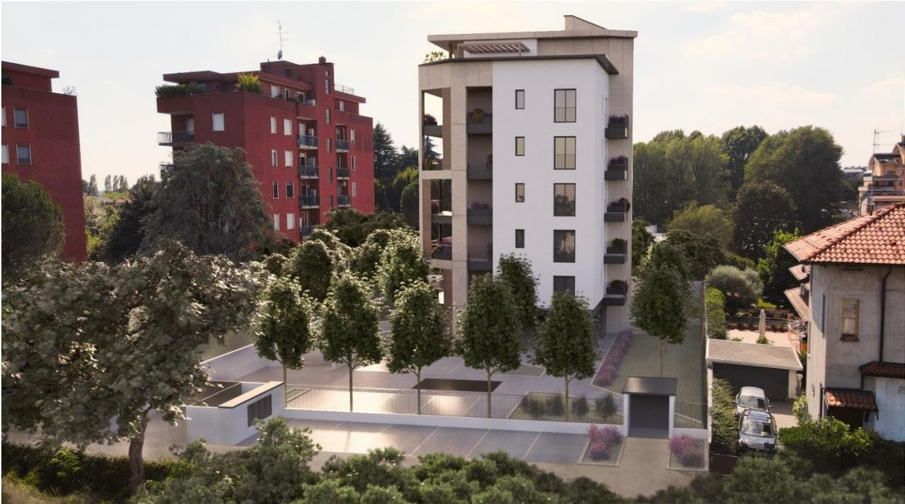
L'intero edificio a piano terra sarà inserito in un'area a verde, in parte privata e in parte condominiale. La maggior parte di essa sarà drenante e le porzioni a verde previste sopra il piano interrato saranno realizzate garantendo uno spessore di almeno 80 cm di terra. Le pavimentazioni delle aree esterne scoperte saranno realizzate con materiali drenanti di tipo DRENATECH o betonelle autobloccanti drenanti al 100%.
