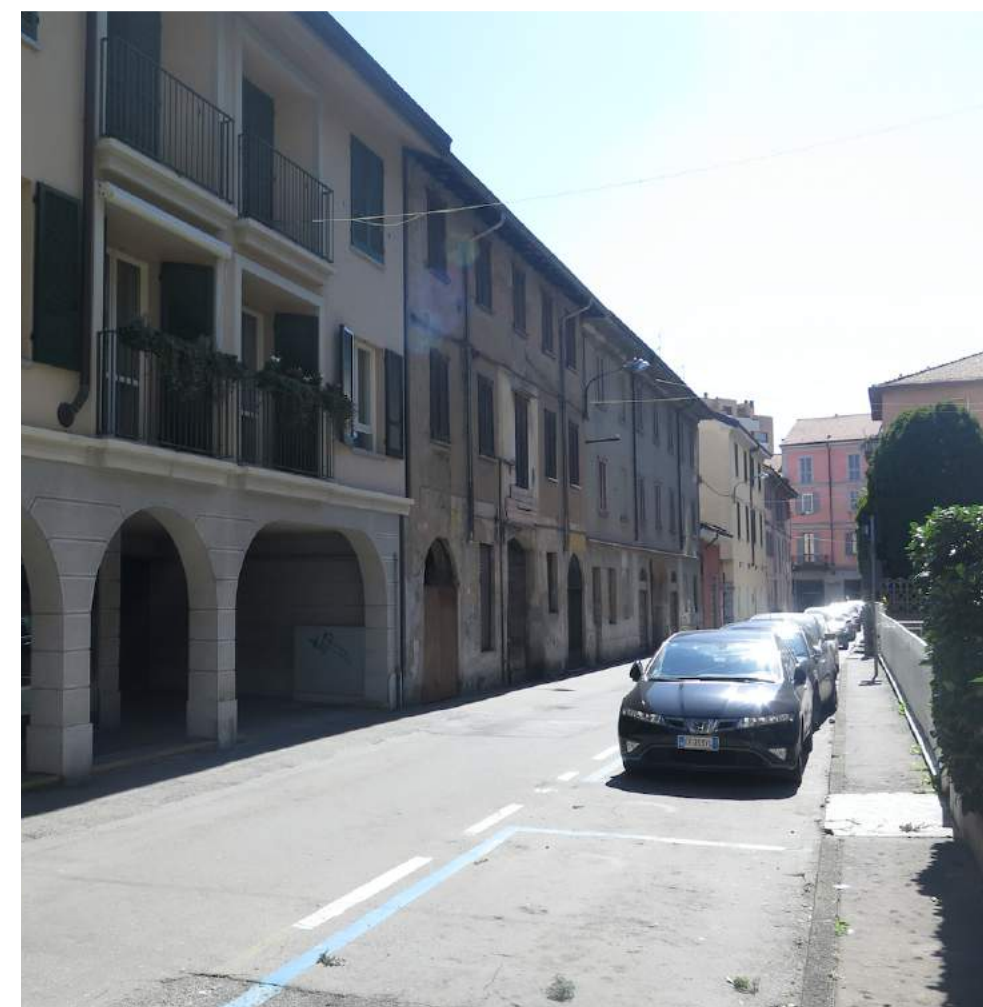
VISTA 6. Prospetto lungo via Genova
