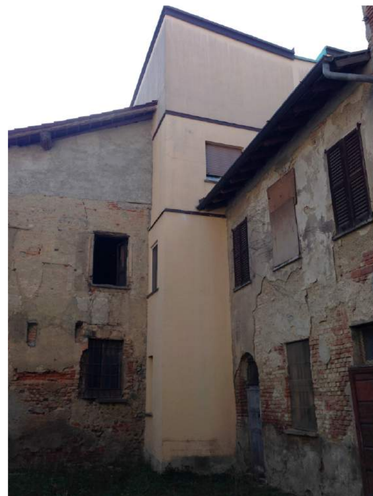
VISTA 7. Corte 1 (Nord)
