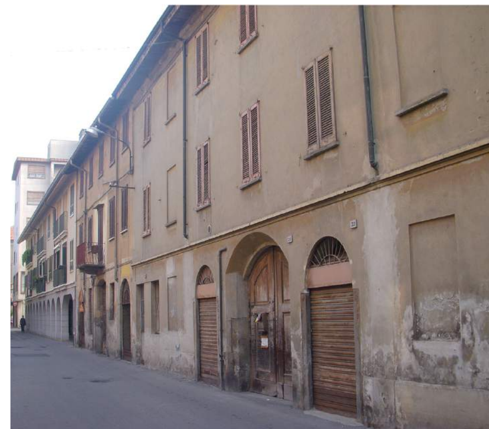
VISTA 1. Prospetto lungo via Genova
