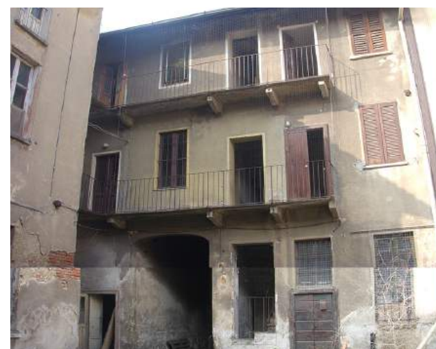
VISTA 8. Corte 1 (Nord)
